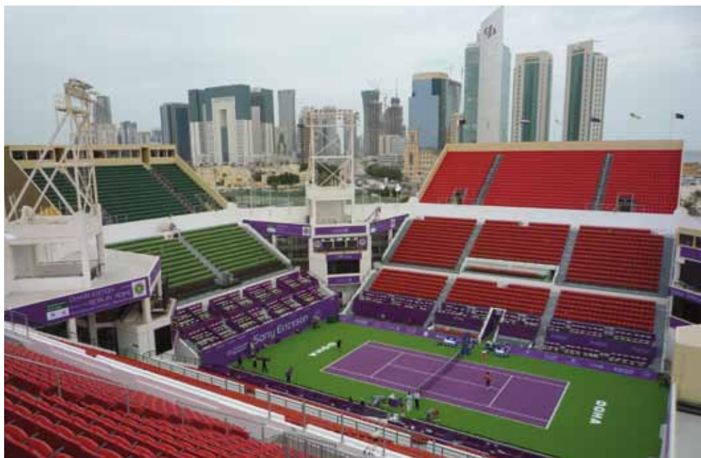
Anspruchsvolle temporäre Bauten: Tennisstadion in Doha, Qatar
