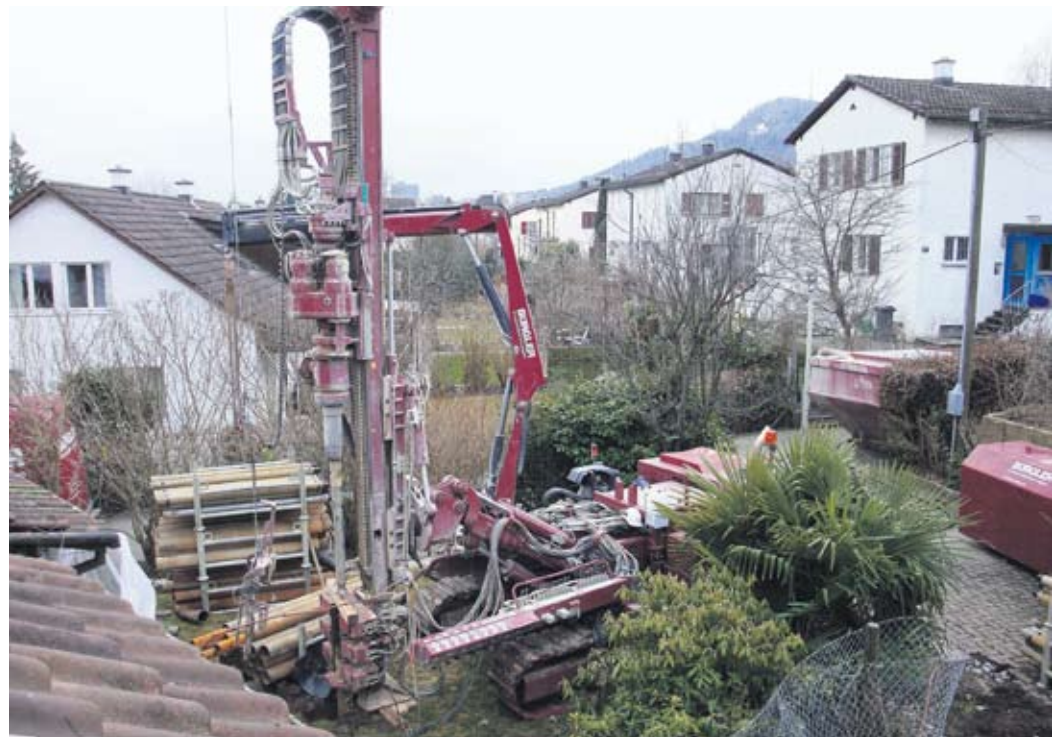
Blick auf eine Baustelle für die Erstellung einer Wärmepumpe.
